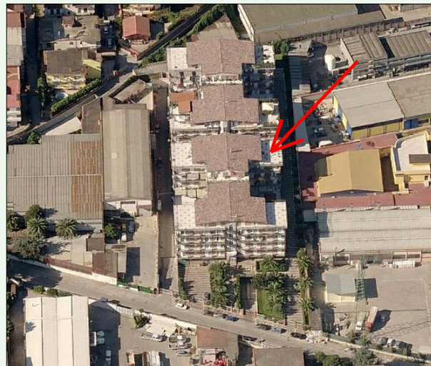
Foto n o 6 - Inquadramento territoriale: lato EST
